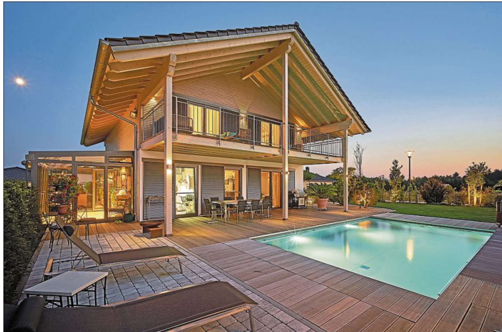
Holzhäuser werden individuell geplant und größtmöglich vorgefertigt.
