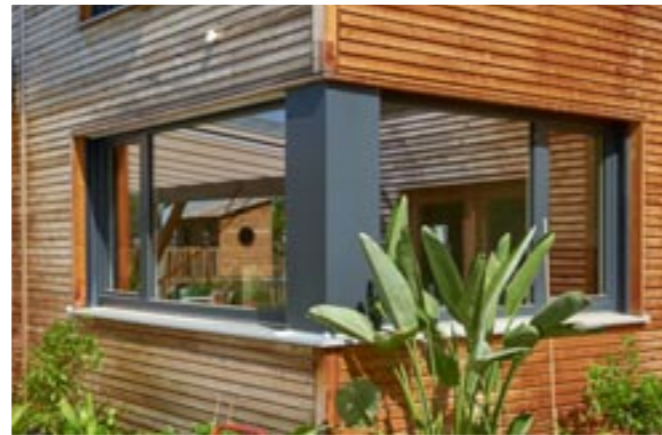
Charakteristische Twinligna-Fassade mit quer gefrästen Nuten. Das Eckfenster zitiert architektonisch das Bauhaus.
