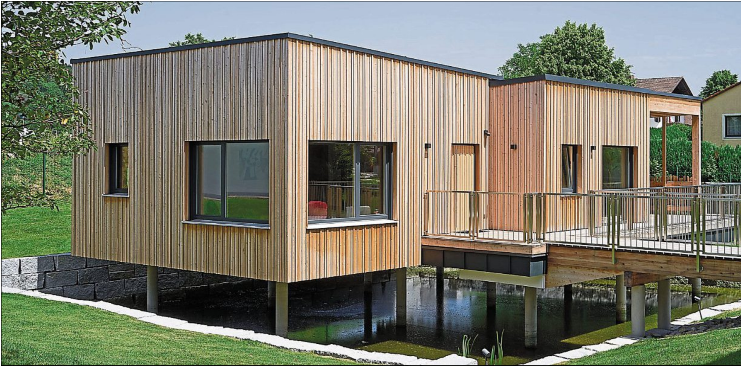
Der in Holzbauweise errichtete Pfahlbau befindet sich über dem Niederschlagsauffangbecken des Firmengeländes.
