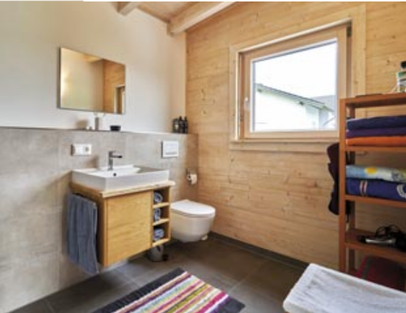
Haus Kempten hat Twinligna-Außenwände. Sie ermöglichen Massivholzschalung auch innen. Als Kontrast zu den Holzbalkendecken ...
